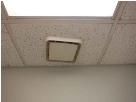
Ventilation : Ventilation Exhaust Fan
